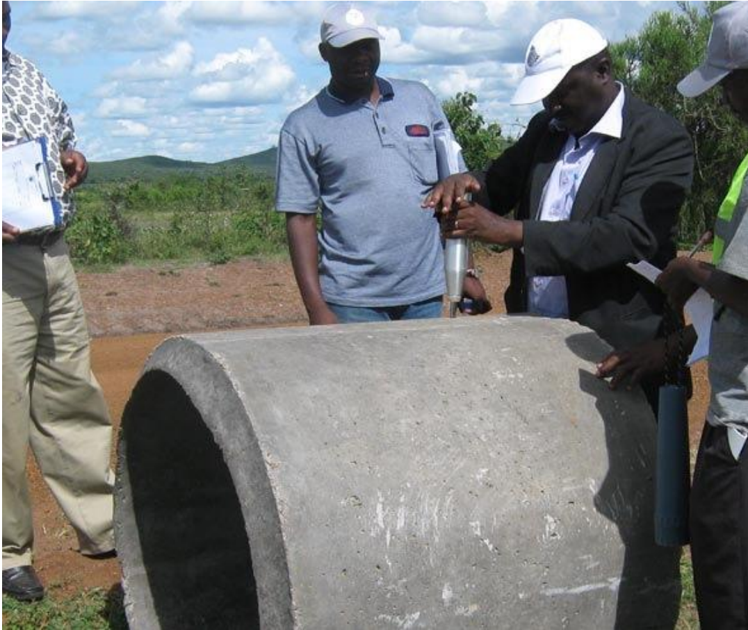
Injinia R. Lwakatare wa Bodi ya Mfuko (wa pili kulia) akikagua ubora wa Kalvati kwenye Barabara ya Gulumungu-Shindai- Mwangiligili, Wilaya ya Misungwi mkoani Mwanza.
